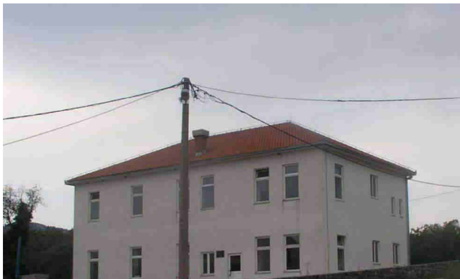
Zgrada osnovne škole u Ravnom
