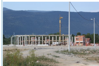
Fabrika peleta u izgradnji
