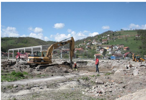
Radovi na poslovnoj zoni "Pilana"
