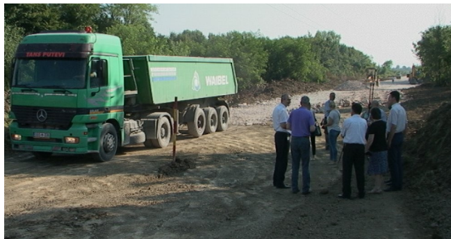
Izgradnja nove saobraćajnice u poslovnoj zoni „Glinište”
